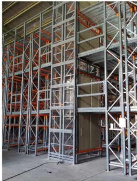
این سیستم عمدتاً در انبارها و یا سالن های طبقه بندی شده جهت حمل کالا به صورت عمودی و در طبقات مختلف استفاده می گردد.
